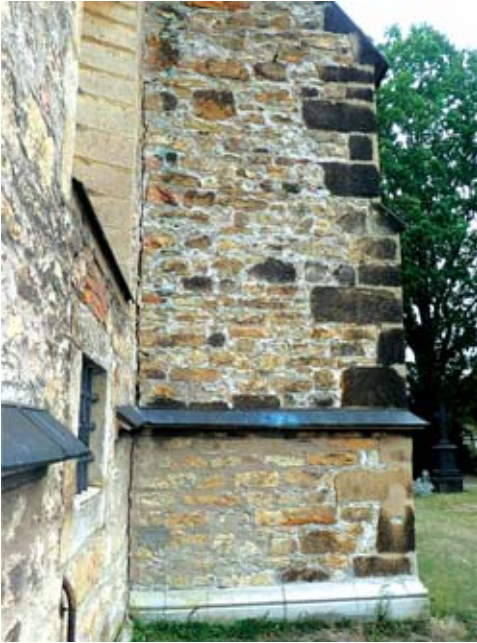
Südfassade, Abriss eines Strebepfeilers von der Außenwand
