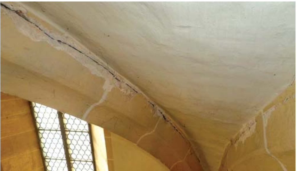
Südseite Chor, Abriss der Sandsteinrippen von der Gewölbeschale
